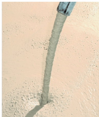
Eingiessen des Mörtels
