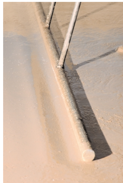
Durch leichtes vibrieren wird der Mörtel einnivelliert
