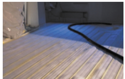
Berechnung Kabelabstand: m^2 : Kabellänge = Kabelabstand z.B. 20 m^2 : 110 \text{ lm} = 18,2 \text{ cm} Abstand
